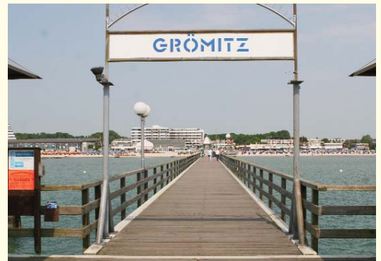
398 Meter lange Seebrücke
